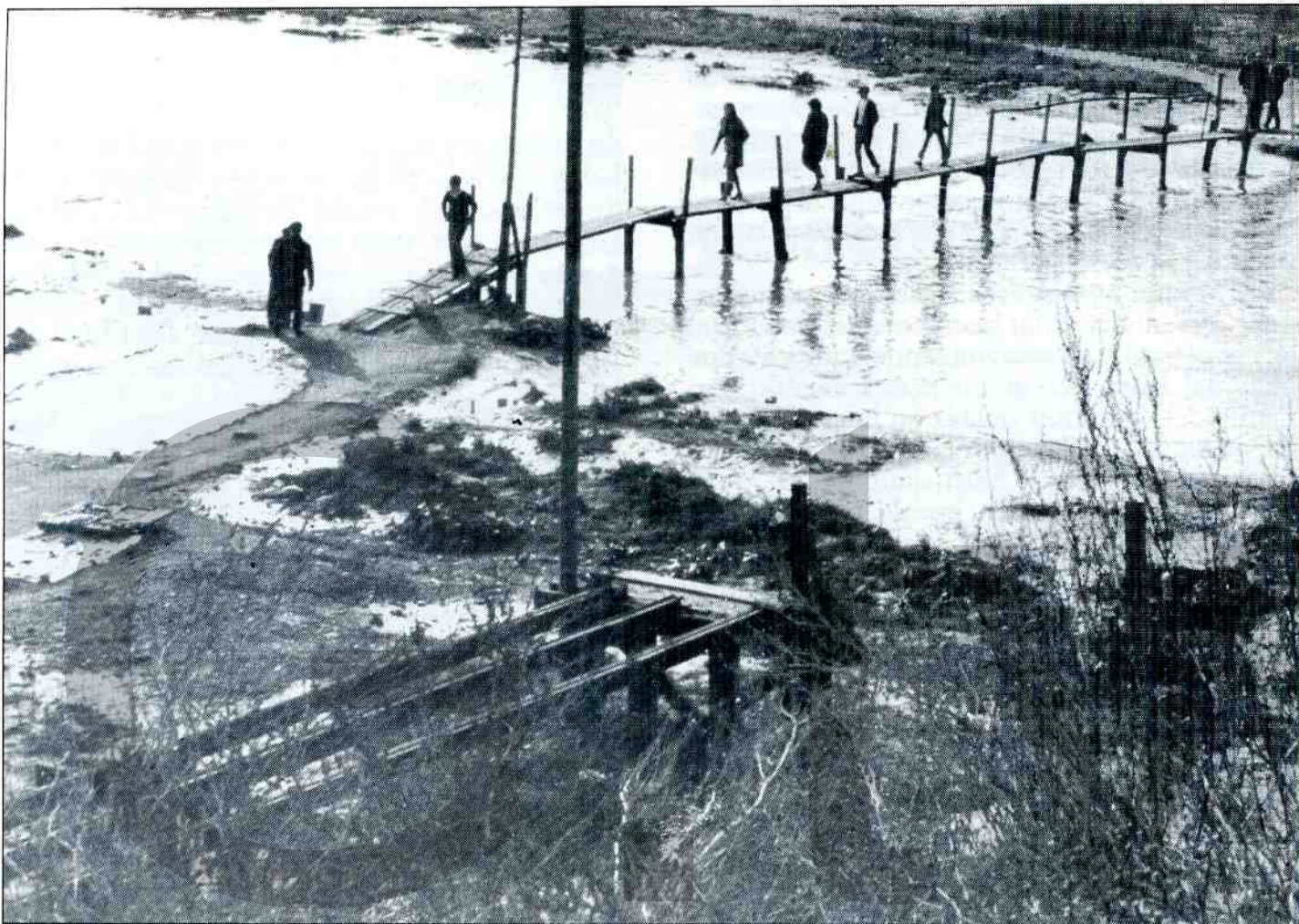
Els ponts van ser destruïts.
