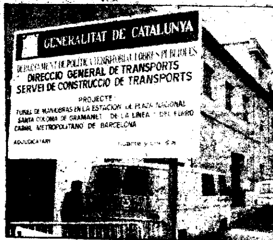
Las obras durarán más de un año
