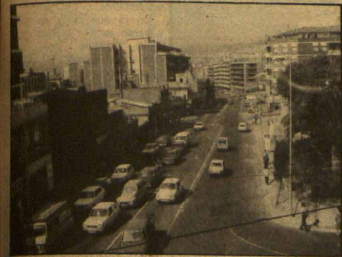
El Paseo Llorenç Serra y la Rambla, uno de los puntos a reformar
