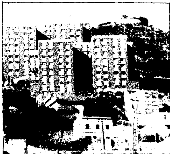
En el Pleno de hoy se hablará de las reparaciones en Can Franquesa
