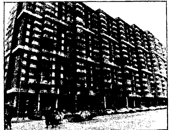
Aquests blocs són l'origen del problema
